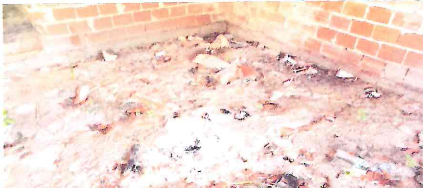
Piso interno (inexistente)
