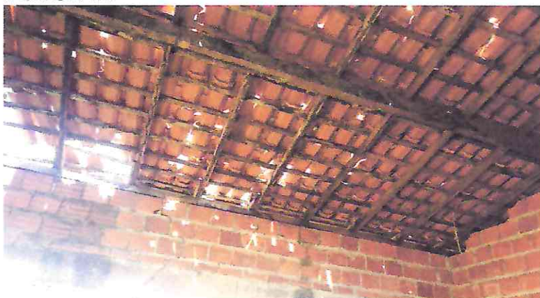
Telhado a ser construído
