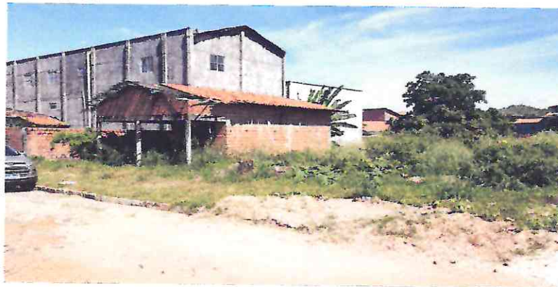
Vista da área de localização da futura sede
