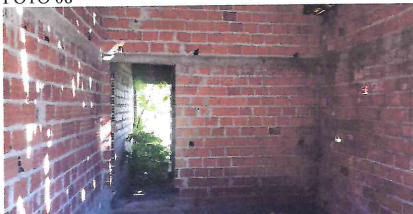
Paredes (complementação e aumentar altura)
