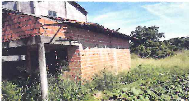
Vista frente/lateral da edificação
