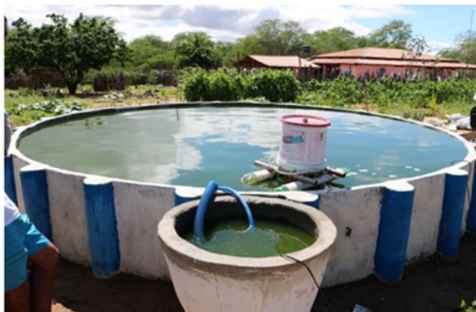
**Figura 2: Kit Sedimentador e Recirculação**
