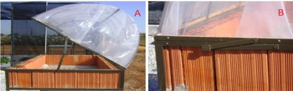
Figura 3 A e B: Detalhe do suporte articulado aberto e fechado.
