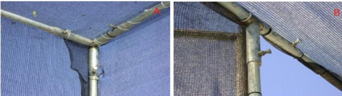
Figura 6 A e B: Conexão dos vértices da estrutura em tubos de 1" soldados, com parafusos de travamento sextavados; Conexão entre a travessa frontal superior e as colunas do portão em "T" feitas em tubos de 1" soldados com parafusos de travamento sextavados.
